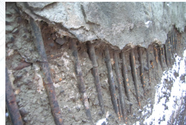
Разрушение бетона в сводовой части самотечного коллектора сточных вод в результате биологической коррозии
