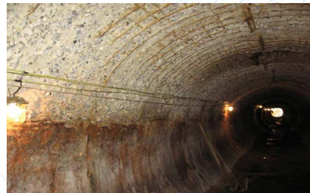
Разрушение бетона в сводовой части самотечного коллектора сточных вод в результате биологической коррозии
