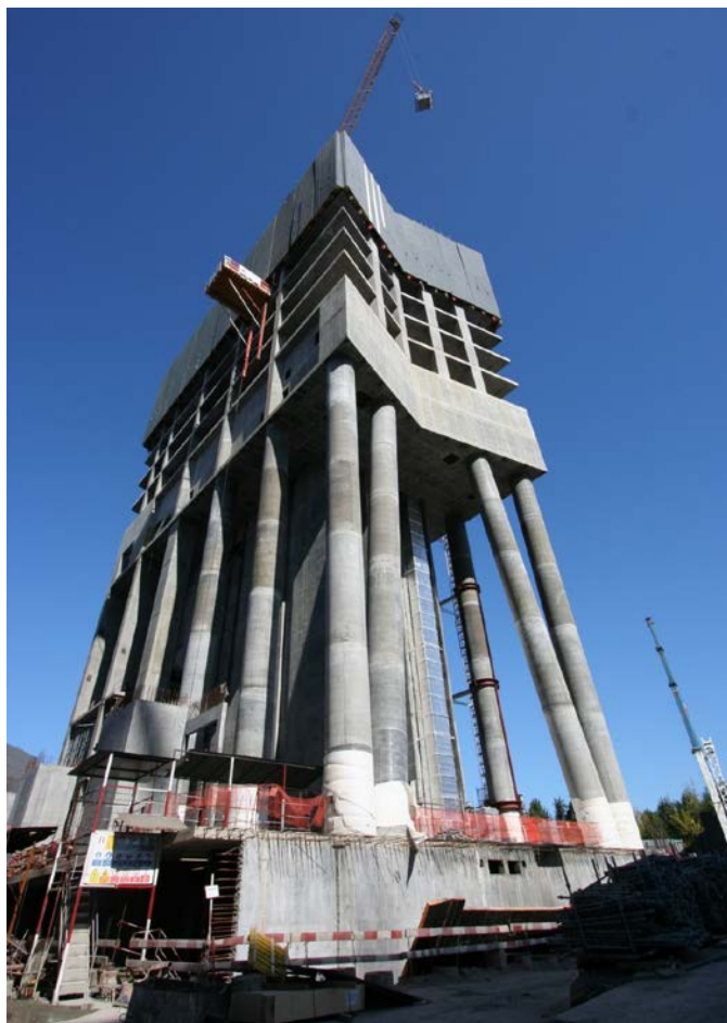
Конструкции высотного здания
