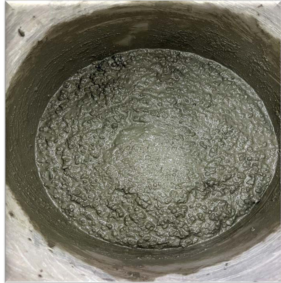
Приготовление бетонной смеси
