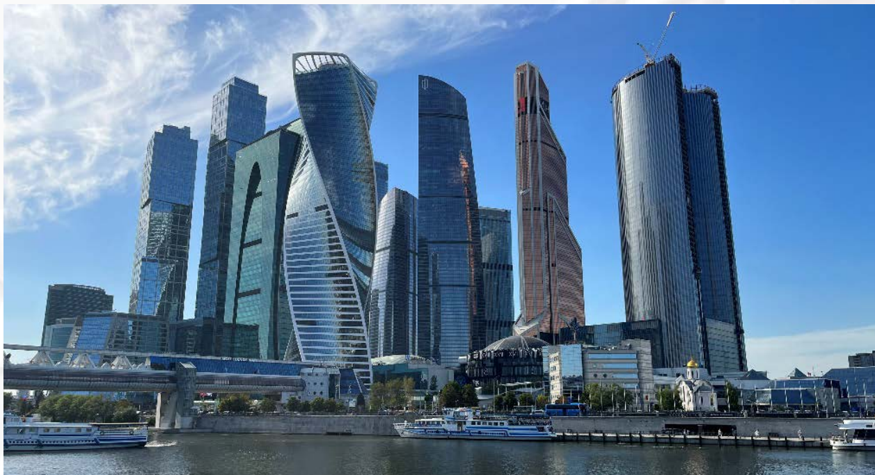
Монолитные железобетонные и сталебетонные конструкции каркасов высотных зданий ММДЦ «Москва-Сити» из самоуплотняющихся бетонов классов В60-В100
