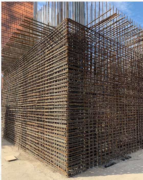
Армирование конструкции стен ядра жесткости из бетона класса В90 МК Гранд Тауэр ММДЦ Москва-Сити
