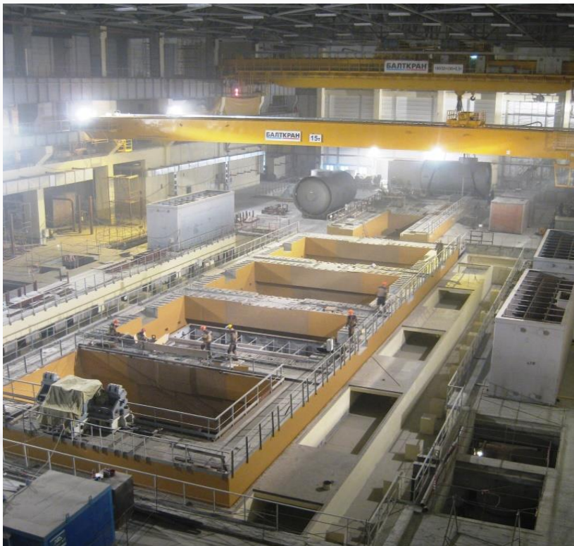
Бетонирование конструкции верхнего строения фундамента турбоагрегата строящегося 4 энергоблока Белоярской АЭС из бетона с модулем упругости E = 30 ГПа
