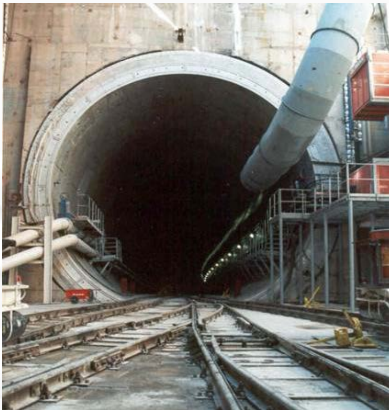
Железобетонные тубинги Лефортовского тоннеля из малоцементного бетона класса В45
