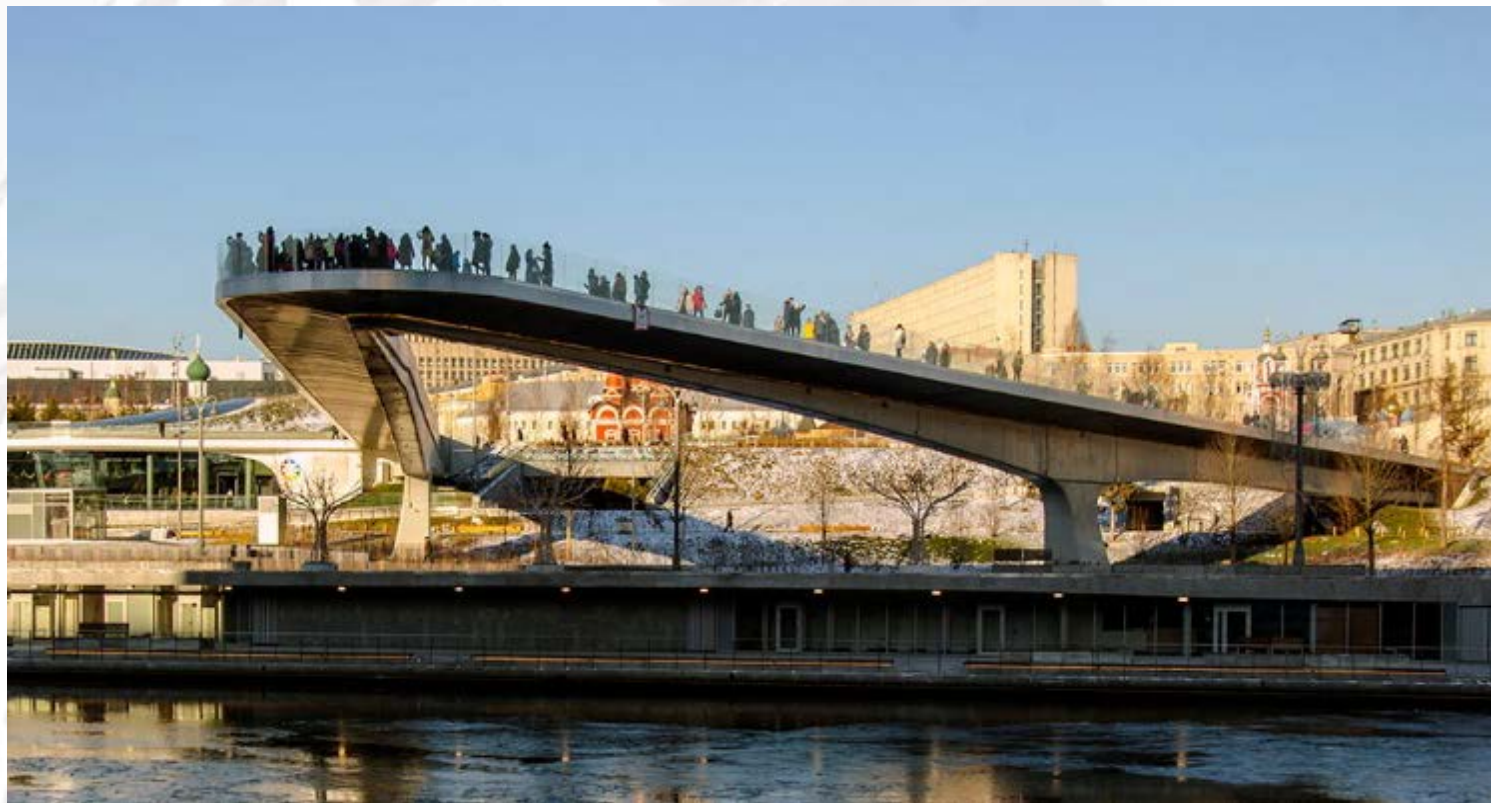
Монолитное постнапряженное пролетное строение «Парящего моста» в парке Зарядье из малоцементного самоуплотняющегося бетона класса В60
