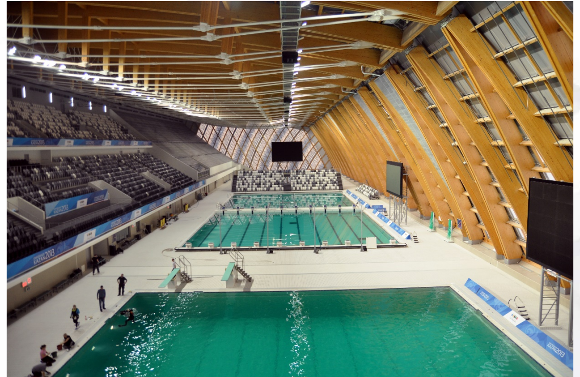
Бетонирование фундаментной плиты и трех чаш бассейнов Дворец водных видов спорта, г. Казань
