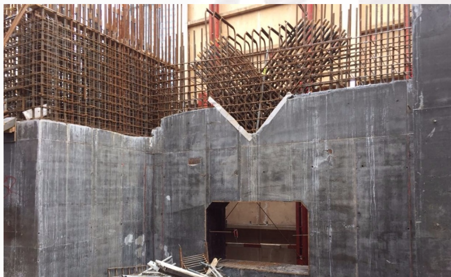
Конструкции аутриггерного этажа из бетона класса В100 МК Нева ММДЦ Москва-Сити
