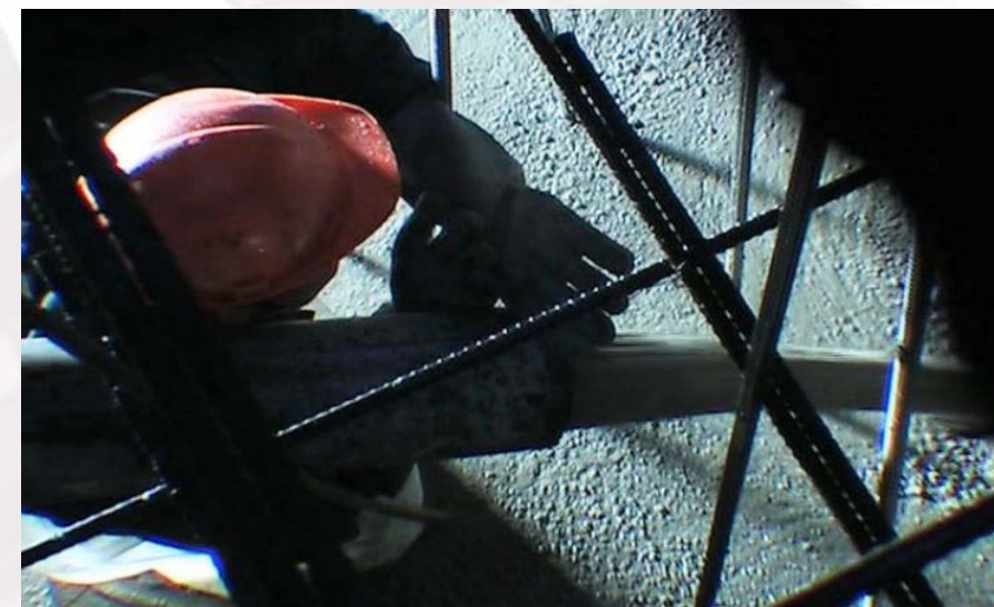
Бетонирование массивной конструкции фундаментной плиты объемом 14 тыс. м 3 из бетона класса В50 МК Федерация ММДЦ Москва-Сити
