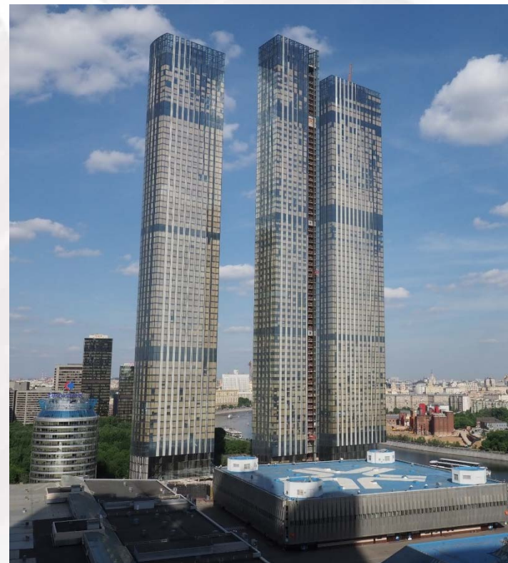
Бетонирование вертикальных конструкций каркаса Высотного жилого комплекса Капитал Тауэр из высокопрочных самоуплотняющихся бетонов классов В60-В100 с модулем упругости E = 42-47 ГПа
