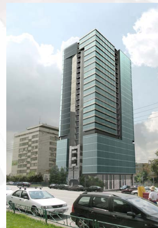
Монолитные конструкции каркаса здания Газойл-плаза высотой 96 м из легкого бетона В45-В55 D1800
