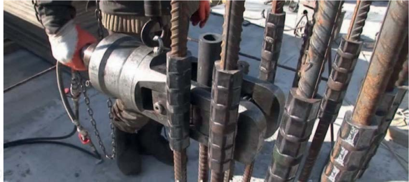
Обжимное механическое соединение
